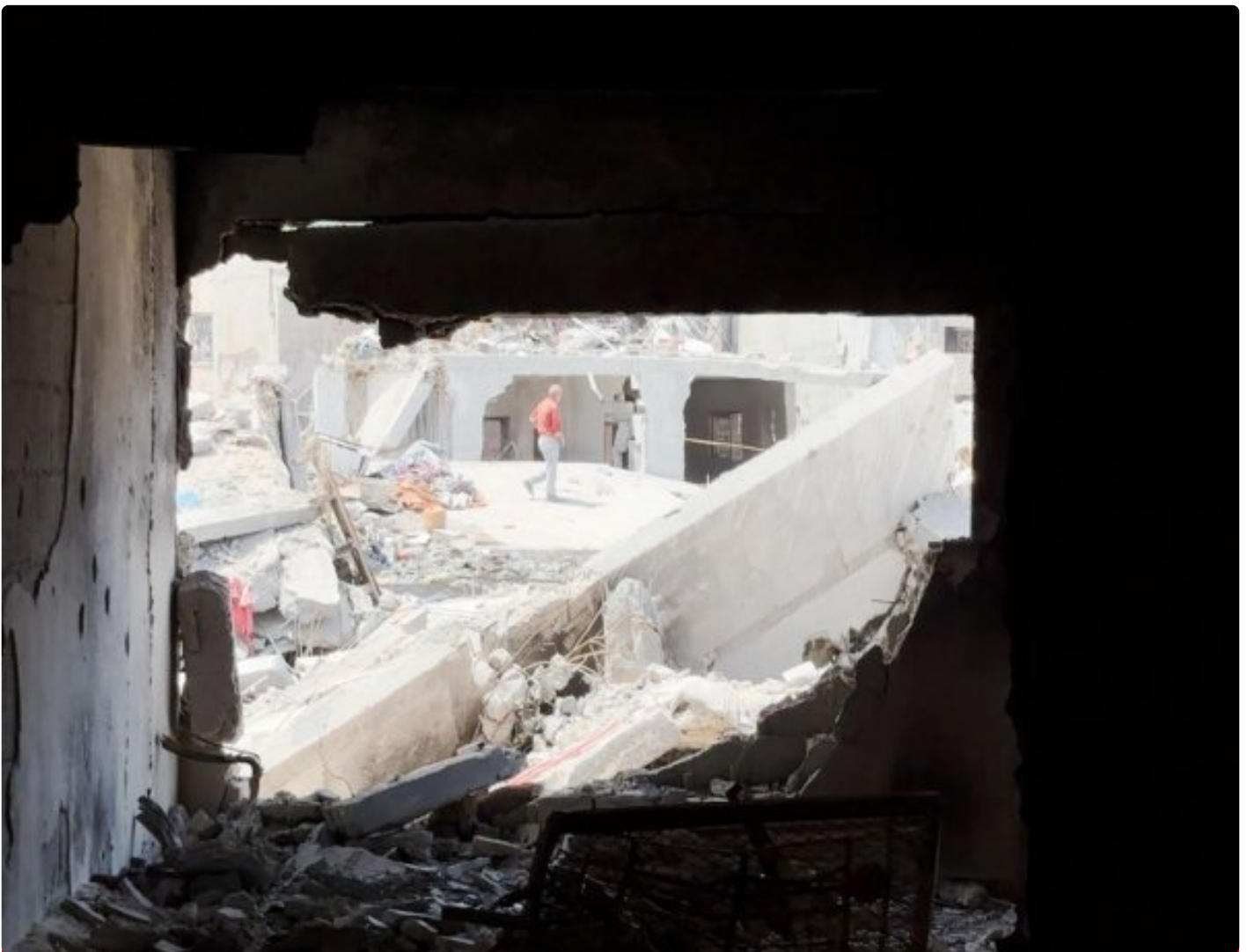
Seorang laki laki berjalan melewati puing-puing di Khan Younis
